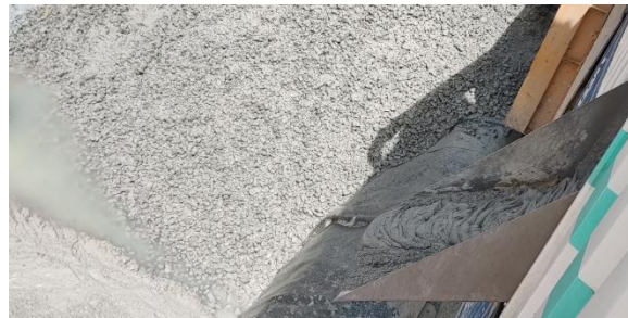
Figura 3.b Scarico solido in alleggerimento
