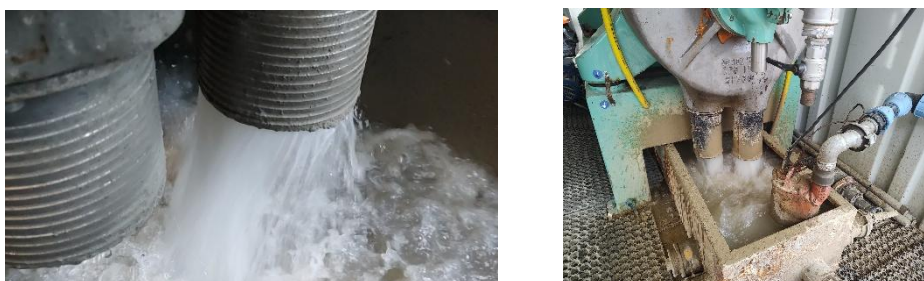
Figura 10. Scarico liquido dalla centrifuga – Acqua pulita
